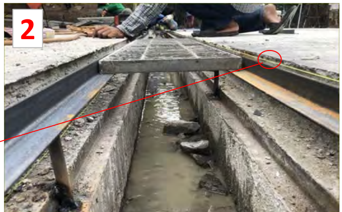
1 - 2 ตั้งระดับน้ำ ชั่งเส้นเอ็น เพื่อทำแนวระดับให้บ่าไม่สูงต่ำ
