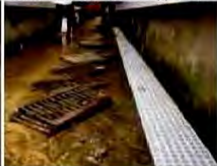
ตลาดสดบางกะปิ
