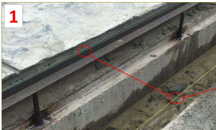
1 - 2 ตั้งระดับน้ำ ชั่งเส้นเอ็น เพื่อทำแนวระดับให้บ่าไม่สูงต่ำ
