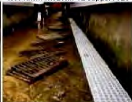
ตลาดสดบางกะปิ
